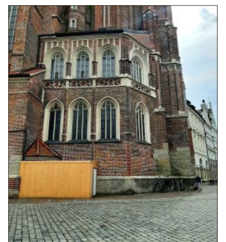
Die vier unteren Fenster der Altdorferkapelle werden neu gestaltet.
