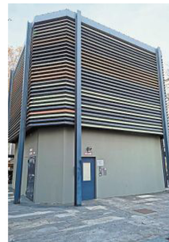
Öffentlicher Fruhtrunk: Die Ummantelung eines Lüftungsschachts in Stachus-Nähe ist wirklich eine Schau. Foto: cis
